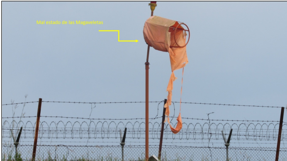
Fotografía No. 5: Manga veletas deterioradas.
