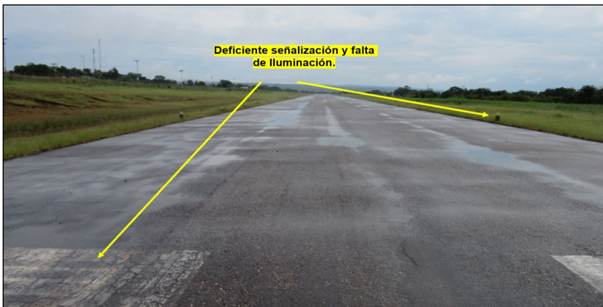
Fotografía No. 4: Marcación de pista poco visible.
